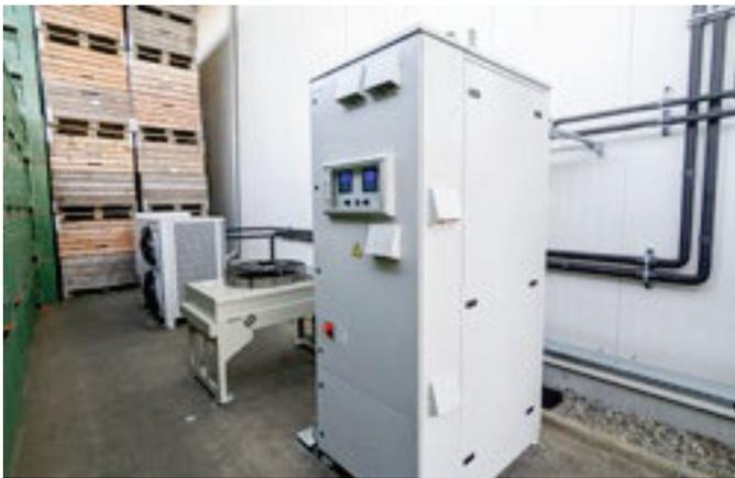
**Fig. 3 : installation CO<sub>2</sub> et propane en comparaison directe (KOB).**
